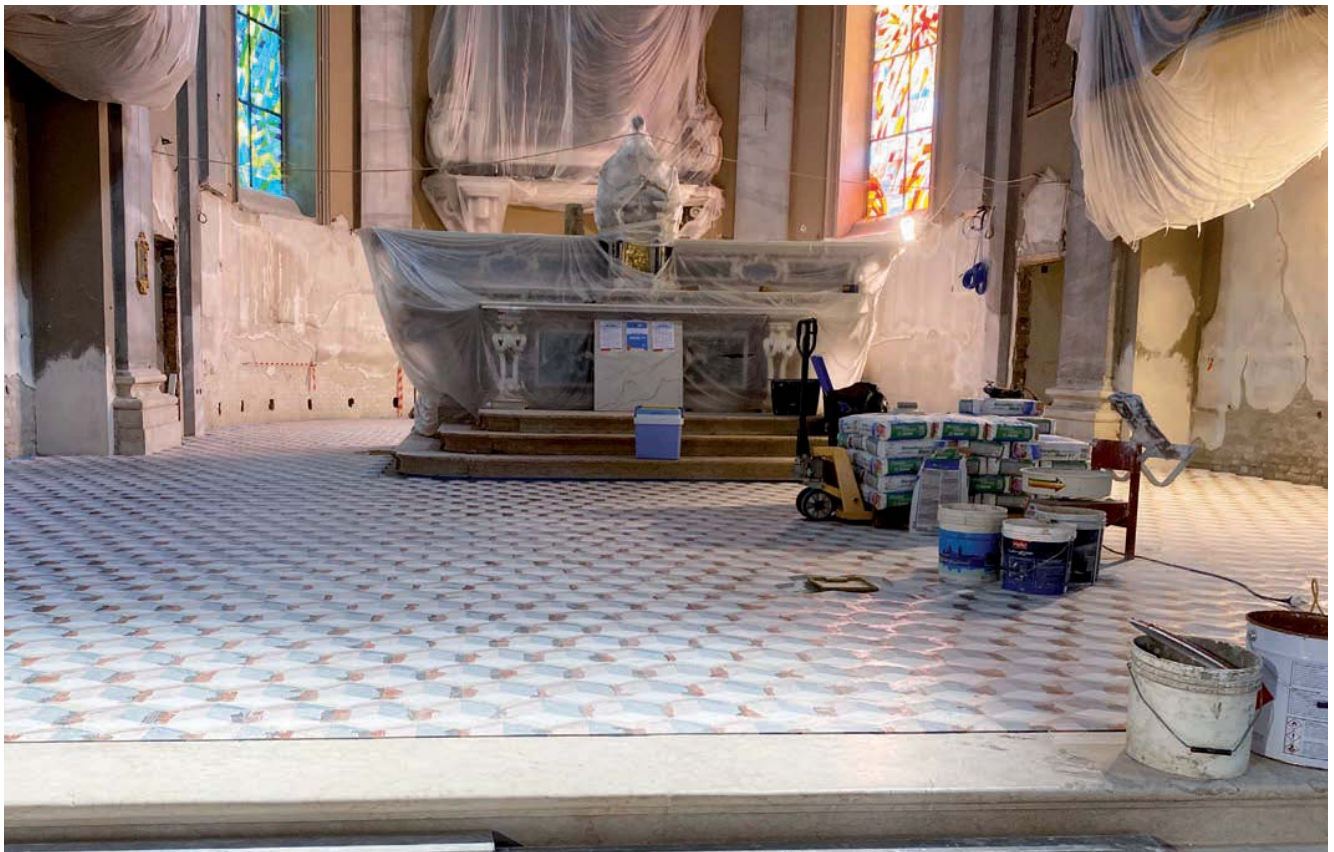
Posa pavimento del presbiterio
